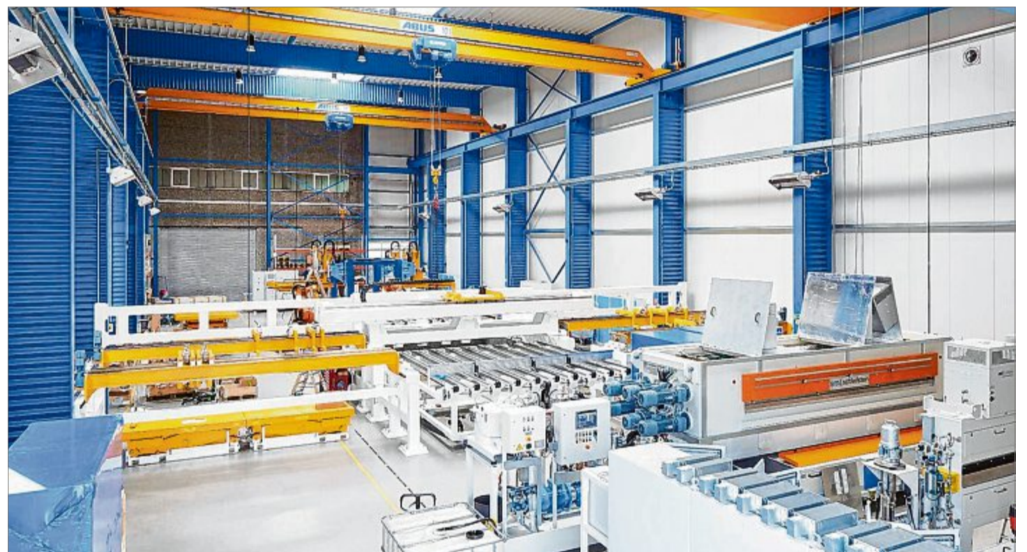
Das Unternehmen bekennt sich zum Standort Weidenau: An der Einheitsstraße wurde eine weitere, etwa 2000 Quadratmeter große Montagehalle errichtet. Im kommenden Jahr soll zudem ein vierstöckiger Anbau an das bestehende Bürogebäude fertiggestellt werden.
